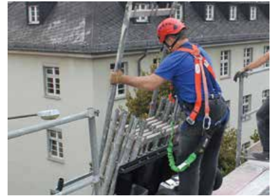
Déchargement facile et en sécurité du matériel d'échafaudage
